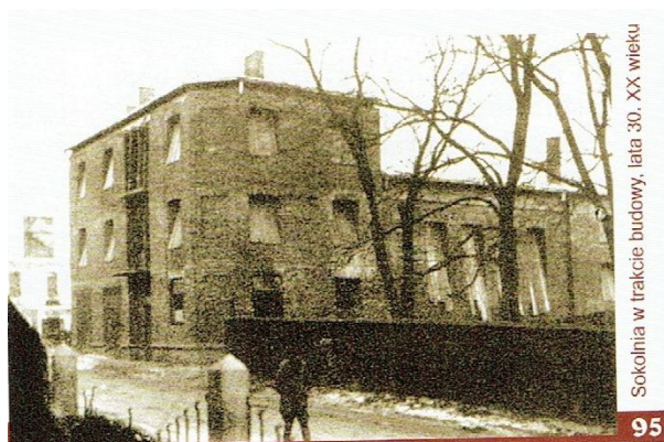
Dom Sokola w Lesku w budowie
