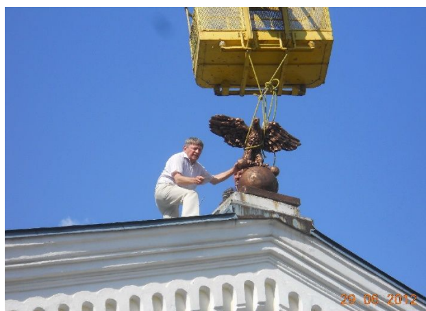
2012-06-29 – Bronisław Kielar na dachu Domu Sokoła w Sanoku w trakcie wystawiania rzeźby sokoła na swoje miejsce.
