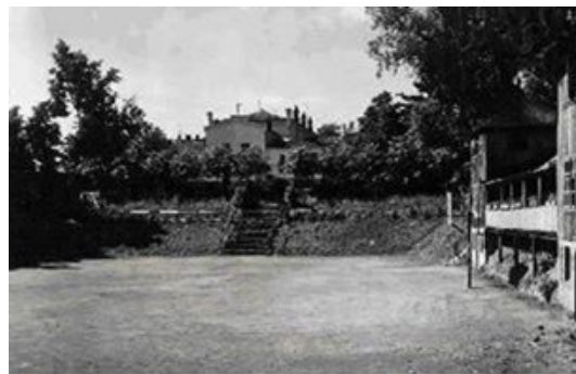
Boisko sportowe budowane przez Sokołów, na podmokłym terenie w okresie 1925-1929. Boisko użytkowano do 1939 r. Widoczne schody prowadzą na Kort tenisowy koło Domu Sokoła.
