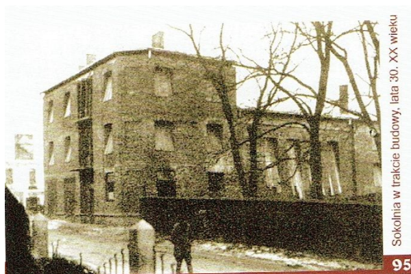
Dom Sokola w Lesku w budowie
