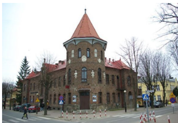
Dom Sokola w Brzozowie wybudowany w 1910 r.
