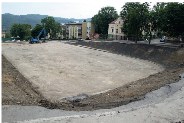
Czerwiec 2013 — płyta byłego lodowiska
