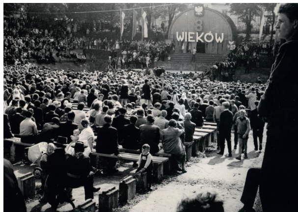
1962 — amfiteatr urządzony na płycie po basenie
