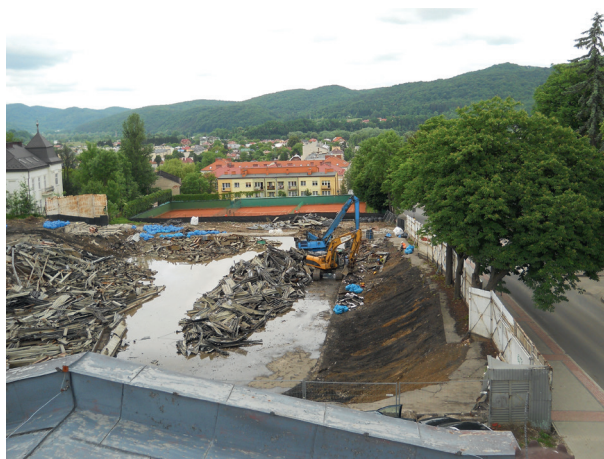
5 czerwca 2013 r. — demontaż konstrukcji zadaszania
